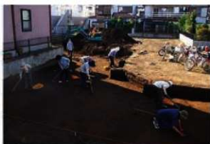
2. 表土剥ぎ風景
