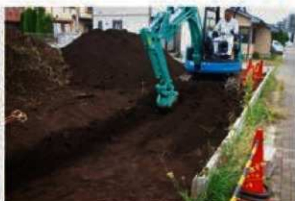
2. 表土剥ぎ風景
