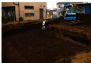
2. 表土剥ぎ風景
