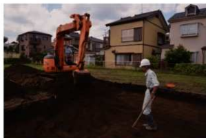
3. 表土剥ぎ (東から)
