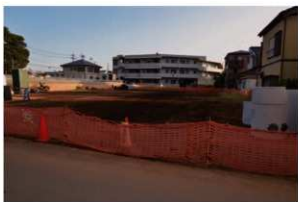
5. 埋め戻し後全景
