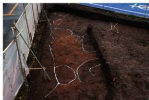
3. 1区プラン確認(東から)
