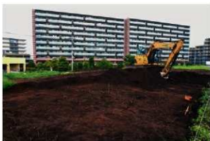
2. 2区表土剥ぎ(西から)
