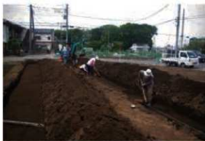
1. 確認調査風景
