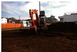
3. 2区表土剥ぎ風景
