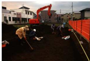
2. 1区表土剥ぎ風景
