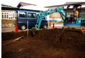
2. 表土剥ぎ風景
