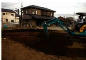
2. 表土剥ぎ風景
