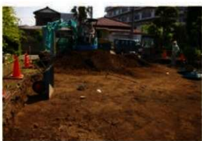
2. 表土剥ぎ風景
