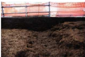
6. 1号段切状遺構断面（西から）
