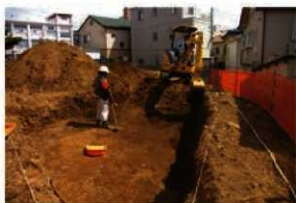
2. 表土剥ぎ風景
