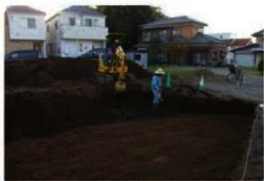
2. 表土剥ぎ風景
