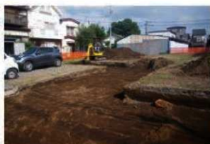
2. 表土剥ぎ風景
