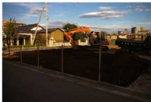
2. 表土剥ぎ風景(西から)
