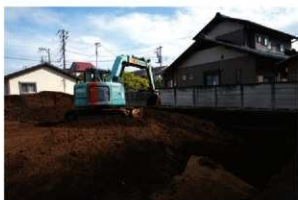
7. 埋め戻し作業
