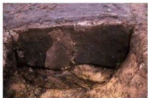
②官道西側溝土層断面【ベルト⑦】（南から）
