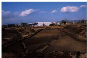
① I区調査区全景（南西から）
