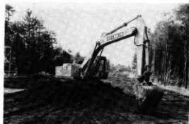
作業風景（表土除去）
