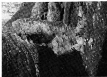
奥壁裏込め状況
