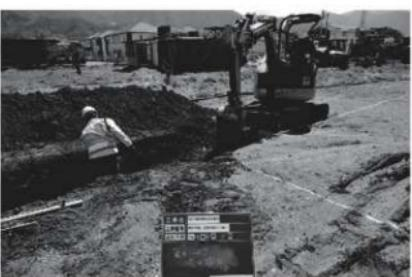
作業風景 重機による表土掘削
