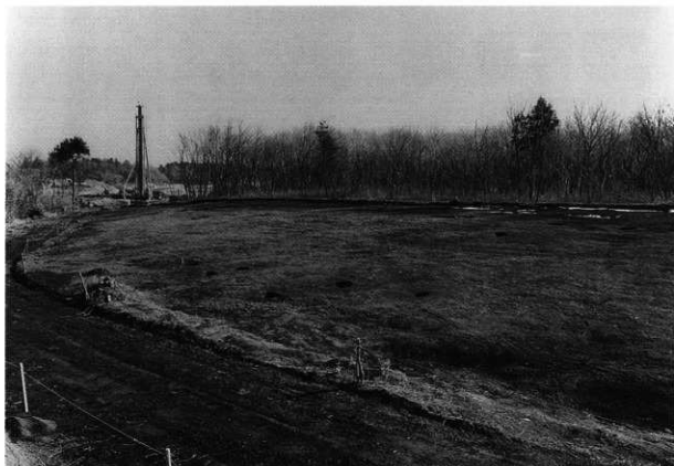
調査終了状況
