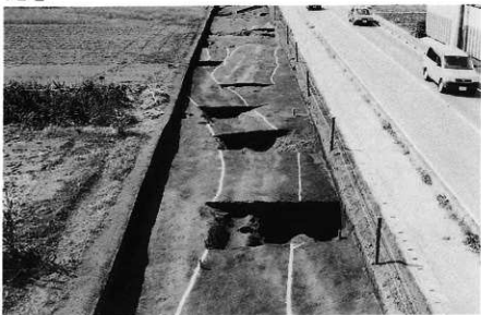
A区 トレンチ
