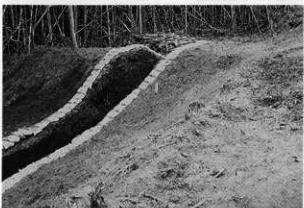
第1号土溝状況
