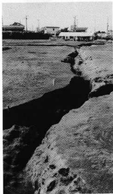
第19号溝完掘状況
