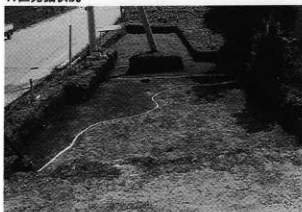
B区遺構確認状況
