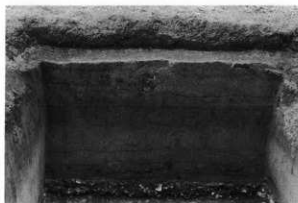
テストピット土層断面
