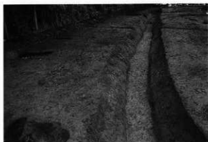
第35号溝完掘状況
