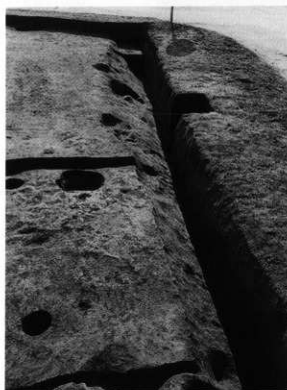
第6号溝完掘状況
