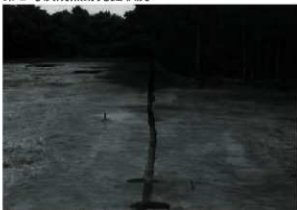
第 1 号溝跡完掘狀況
