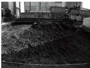
2. 表土掘削作業（北東から）
