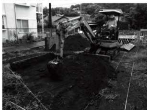
2. 1区 表土掘削状況 (北から)
