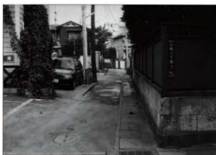
1-1 調査地点近景①(南から)
