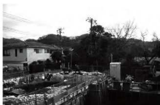
本調査地点から隣接現場を望む (北から)
