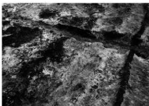
ビット・焼砂確認状況
