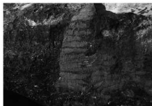
釜屋内版築状況
