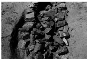
第13号墳 玄門部石材崩落状況
