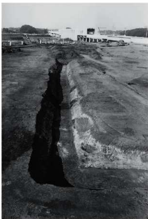
第3号溝跡(方形区画堀跡) 完掘状況 (南西から)
