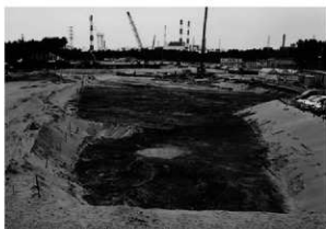
9区遺構確認状況（北部）
