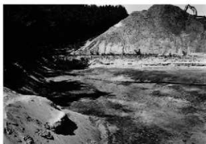
流路跡完掘状況
