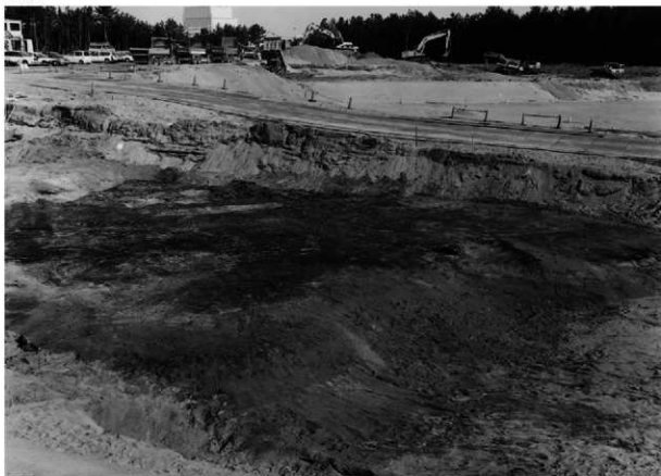
第79号整地面確認状況
