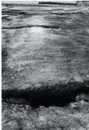
第5号道路跡硬化面確認状況
