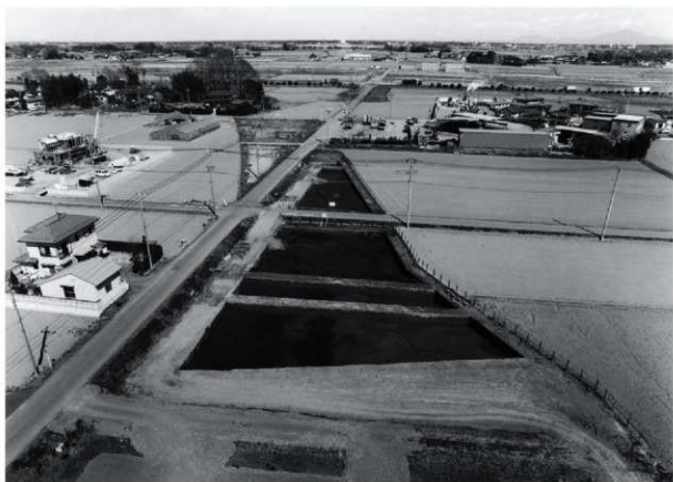
全 景 (南西方向から)
