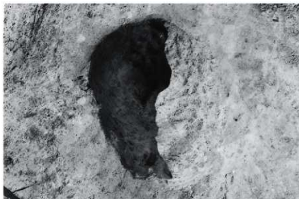
第 1 号 ビ ッ ト 完 掘 状 況
