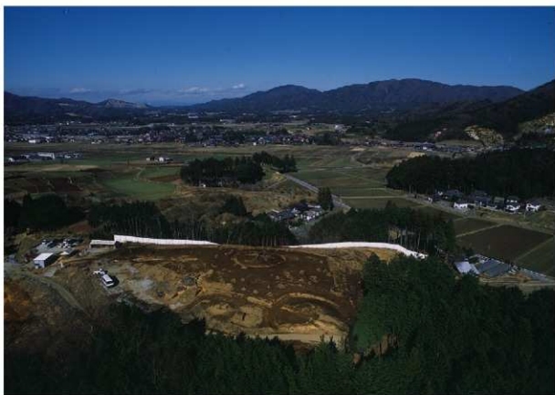
調査区中央部全景（南から）
