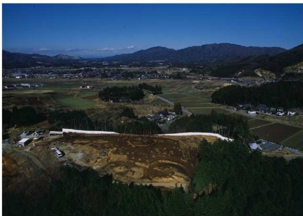
調査区中央部全景（南から）
