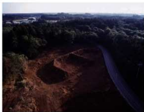
上空から見た第2号掩体壕
