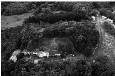
第 5 号 掩 体 壕 全 景
