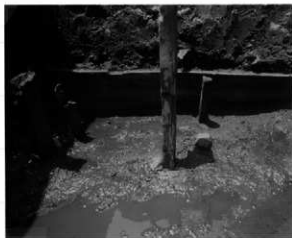
2. 大路側溝部分
