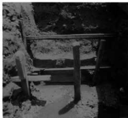
4. ▲大路側溝部分
