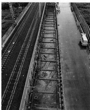
4 第8面全景(難波側から)
