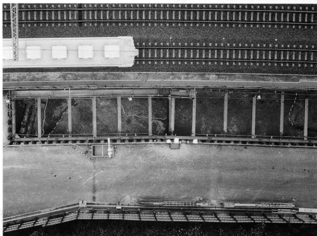
1 最終掘削面東半部(航空写真)
