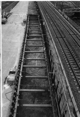
2 最終掘削面全景（和歌山側から）
