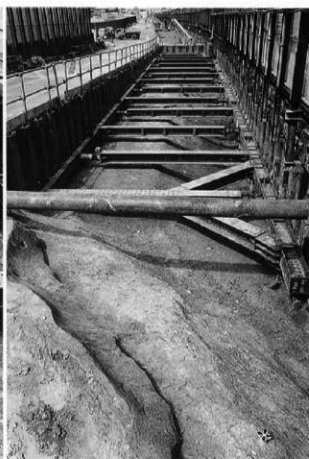
4 線路盛土上面全景4(和歌山側から)
