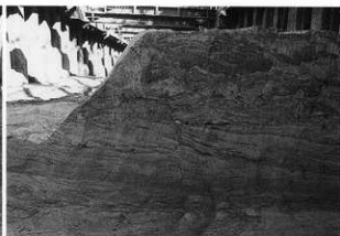
3 地滑り痕土層断面2（和歌山側から）
