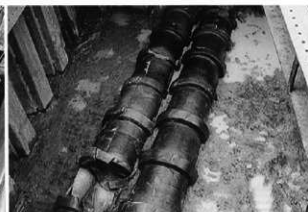
7 盛土層下土管検出状況(海側から)
