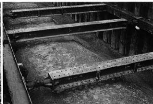
3 線路盛土検出状況 1
