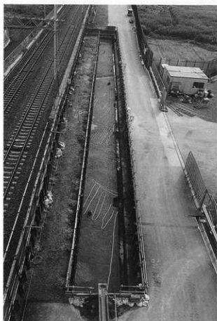
5 第3面全景(難波側から)
