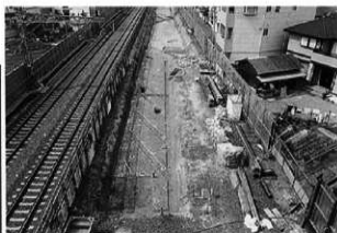
2 最終遺構面全景(難波側から)
