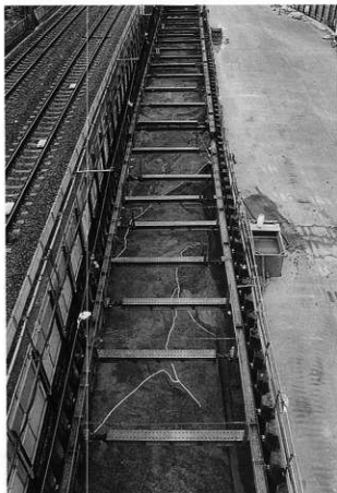
1 最終掘削面全景（難波側から）
