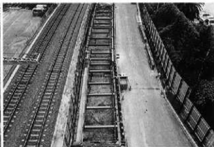
2 第3面相当面全景(難波側から)
