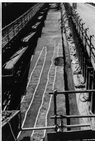
6 第2面全景(難波側から)
