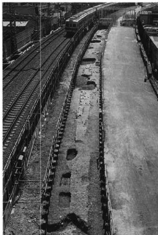
1 最終遺構面全景(難波側から)
