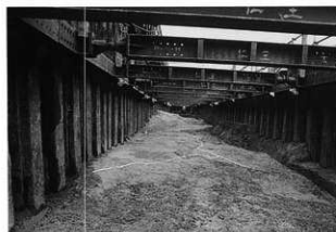
4 最終掘削面中央部（難波側から）
