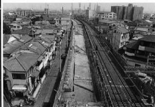
3 最終遺構面全景(和歌山側から)
