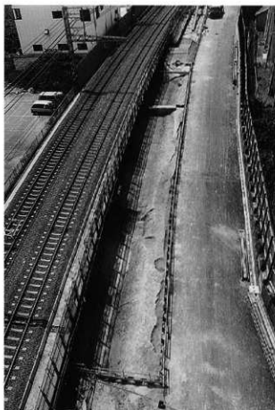
1 線路盛土上面全景1(難波側から)
