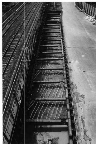
3 盛土層上面（難波側から）
