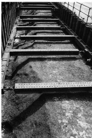
3 線路盛土上面全景3(難波側から)
