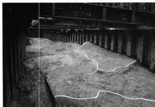
3 最終掘削面中央部（和歌山側から）
