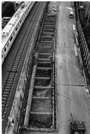
2 第2面全景(難波側から)
