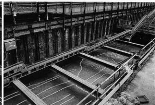
6 第3面 畝溝検出状況
