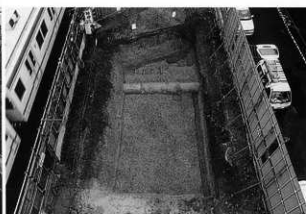
8 西端追加トレンチ(難波側から)
