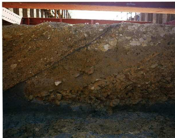
D-1地区（上町東遺跡）線路盛土断面
