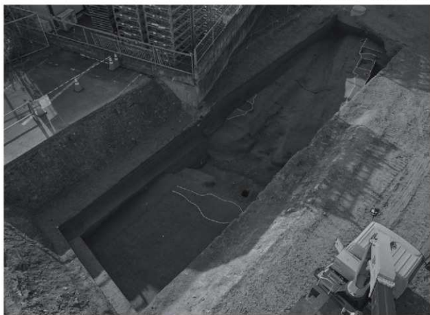
20-1 調査 5 トレンチ 全景 (東から)
