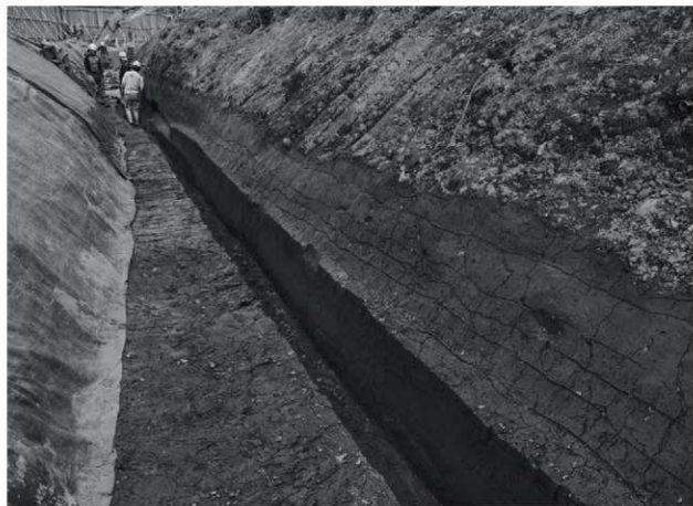
19-1 調査 1 トレンチ 土層断面 (南から)
