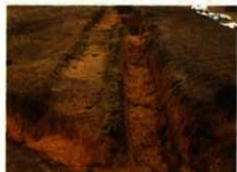
▲ SD-29-31(西側溝)近景(北から)
