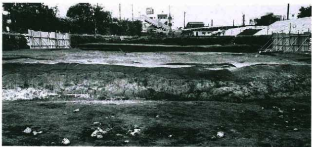
3. No.3セクション中央部(北から)
