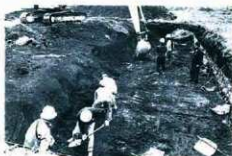
写真4. 表土掘削風景
