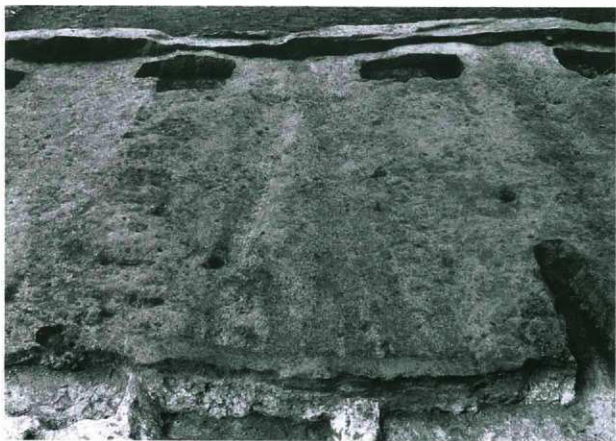
2. SF-2 硬化面検出 (南から)
