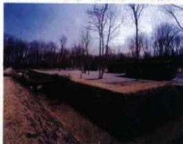
飛山城跡。中世の建物と木橋復元の様子
