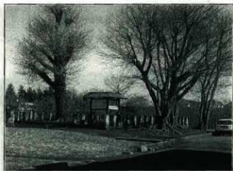
① 塔跡全景（西側より見る）
