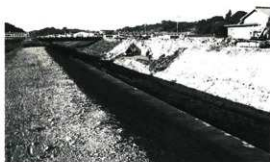
2 中方遺跡 作業風景 (下層部)
