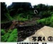
**地点①** 深度約2mの幅20m、奥行き20mの崩壊は(中井信郎氏の)地すべりの證拠面を平坦に整備したものと推定され、1/2,000地図の範囲1m等高線から2箇所の水みち—を整備していました(図1)、2018.3月「計画図」が、2020年7月大雨によって2ヶ所とも平坦面の裏から崩壊が生じた(写真1)。<約中>
