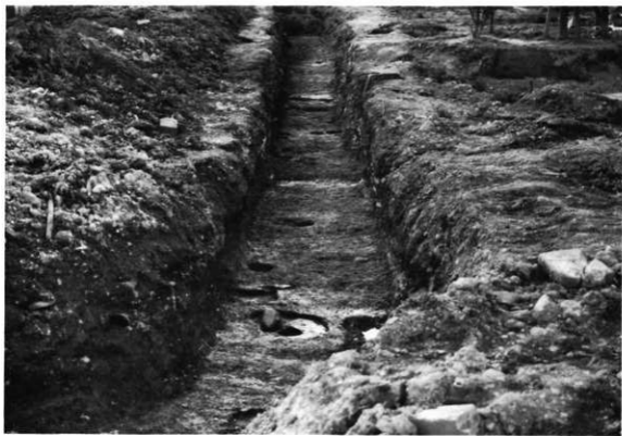
1 調査地全景 (東から)
