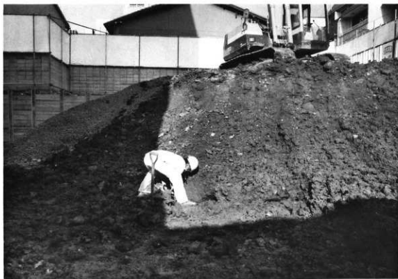
1 No.5 地点調査風景 (西から)
