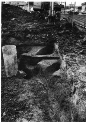
1 SD 3・4完掘状況 (北から)
