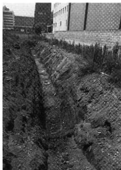
写真7 1トレンチ全景(東から)
