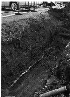
写真8 3トレンチ全景(南西から)
