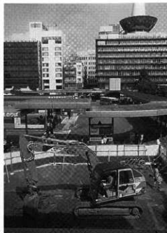
写真12 5トレンチ掘削中(南から)
