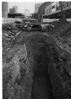
写真11 1トレンチ全景(西から)
