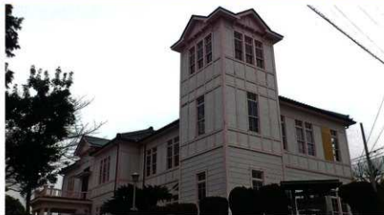
外壁はほぼ更新となり復原される
