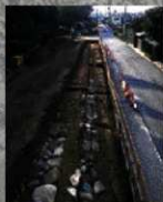
3 上板橋通り(東から) 上板橋通りの拡幅工事で、路面と側溝・石垣が約170mにわたって検出されました。
