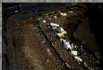
2 伊達街道と上板橋通りの交差点(南西から) 道路の側溝は石組みの溝です。武家屋敷側には石垣を積んでいます。
